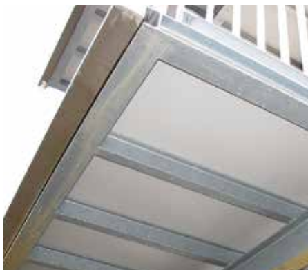
SPODNÍ KONSTRUKCE / NOSNÍKY
