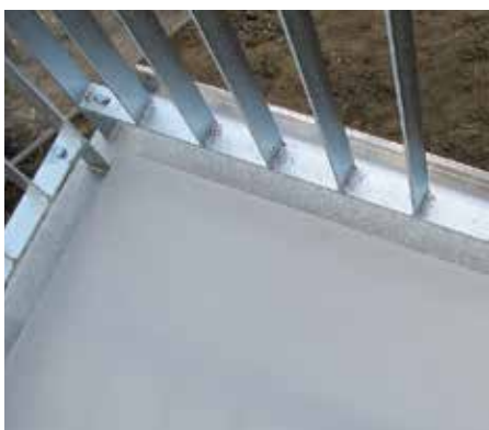
VENKOVNÍ ROH A HRANA
